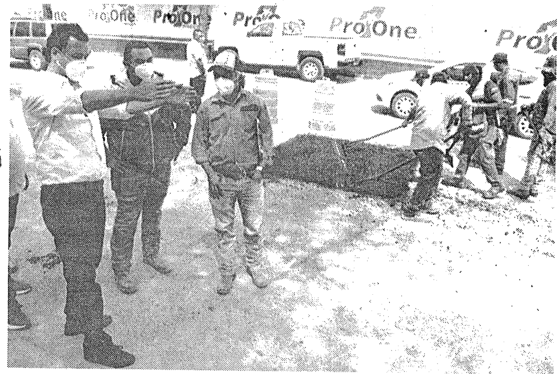
Supervisando los trabajos de bacheo, pavimentación así como de rehabilitación de calles y avenidas aparece el alcalde juarense Lic. Everardo Benavides Villarreal.
