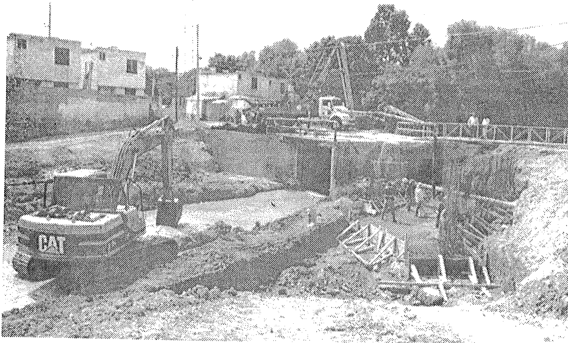
En la colonia Paseo El Sabinal se reconstruye un puente vehicular que se vio afectado durante las pasadas lluvias.
