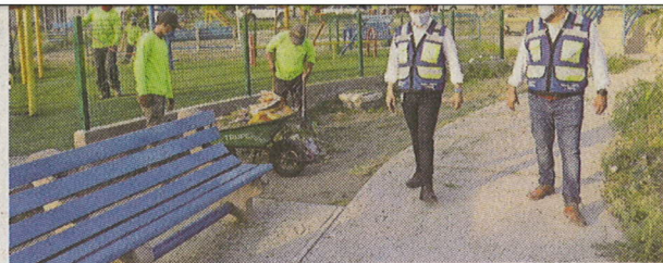
El alcalde Héctor Castillo supervisó los trabajos. FOTOGRAFÍA: ESPECIAL
